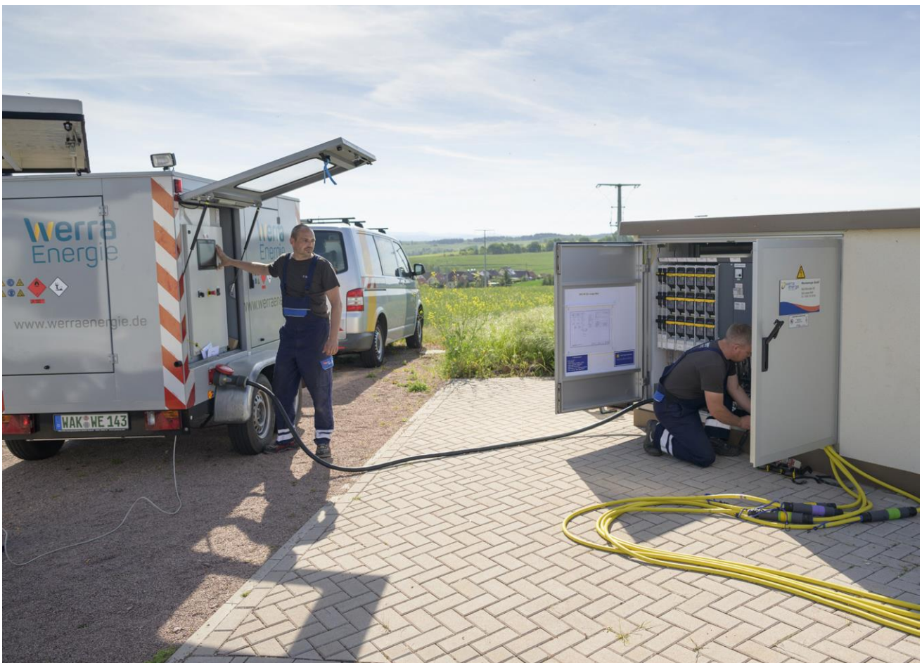
Bild: Foto Schrön - Technische Mitarbeiter der Abteilung Stromnetze während der Übung
