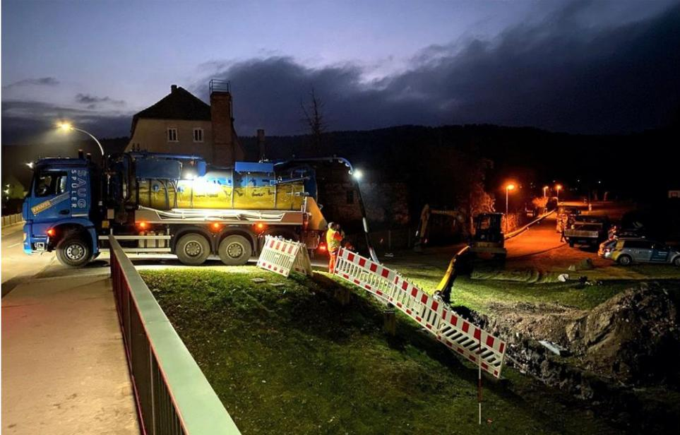
Foto WerraEnergie: Montagabend waren die Arbeiten zur Querung der Gasleitung unterhalb des Flussbettes der Werra in vollem Gange.
