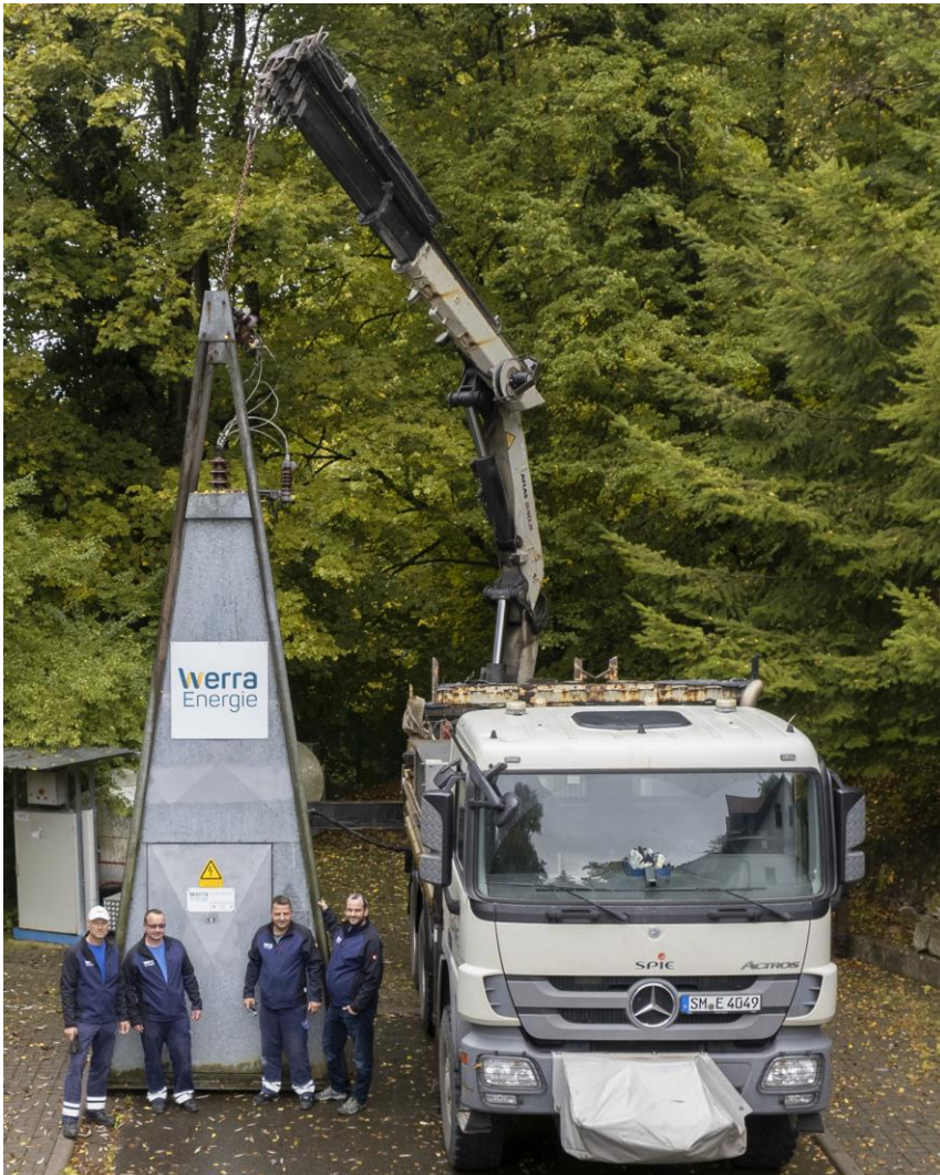
Foto-Atelier Schrön: Eine Station geht auf Reisen. Kurz vor dem Start aus Schmalkalden in das Krisengebiet Ahrweiler. Mirko Eisenacher, Abteilungsleiter Stromnetze der WerraEnergie GmbH (rechts) mit seinen Kollegen (v.l.) Andreas Roßbach , Markus Bickel, André Heber.
