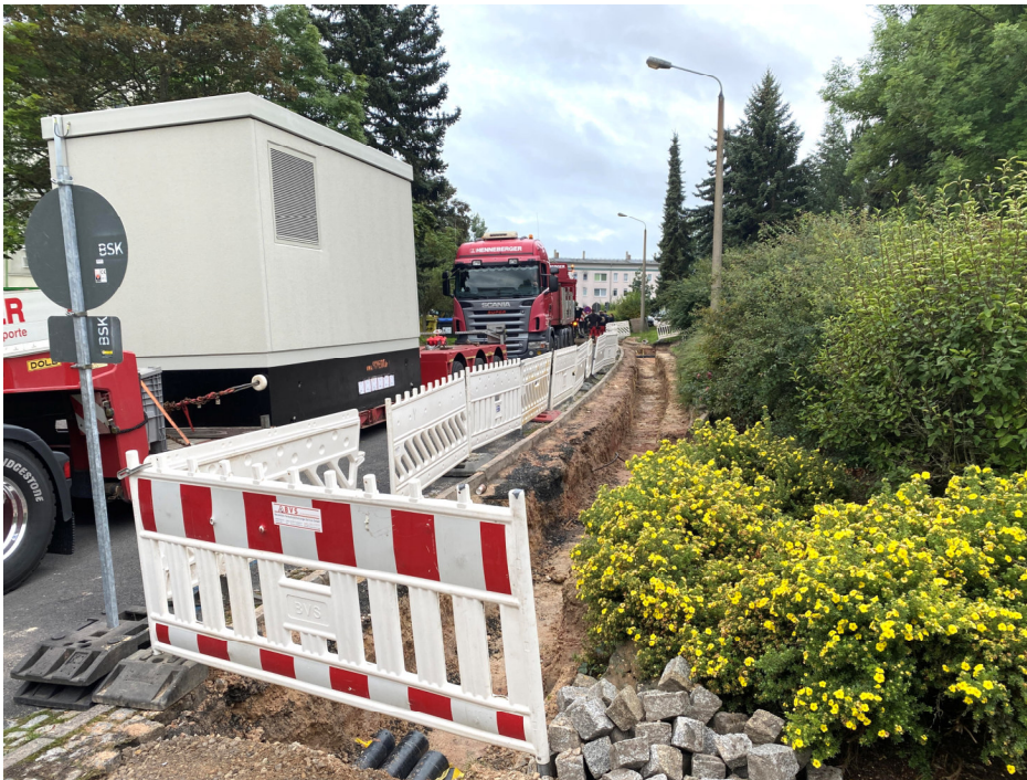
Bild: Anlieferung der neuen Trafostation Quelle: Stadtverwaltung Bad Salzungen
