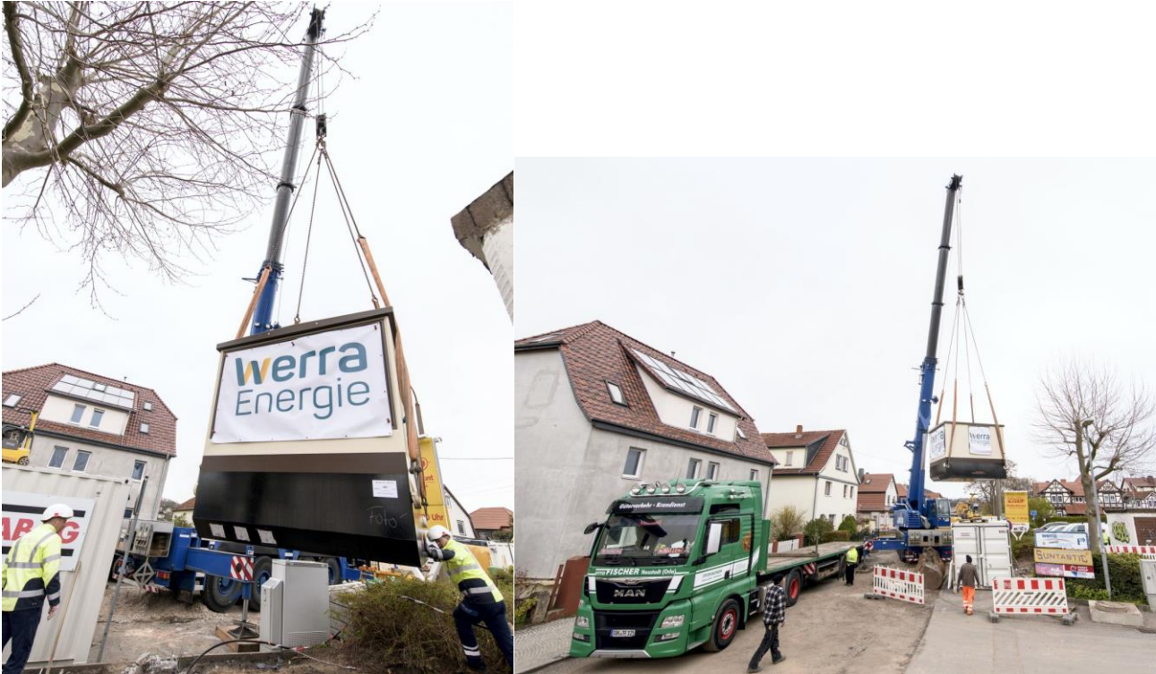
Foto Fotoatelier Schrön: Augenmaß war beim Setzen der Trafostation in der August-Bebel-Straße gefragt.
