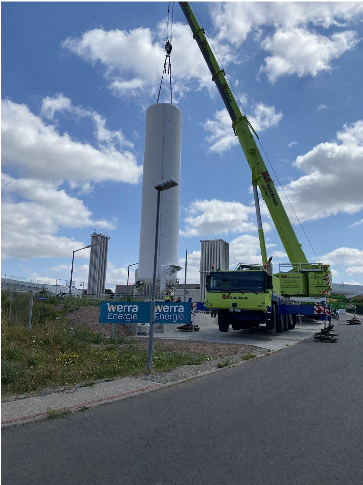
Bild: LNG Tank in endgültiger Position
